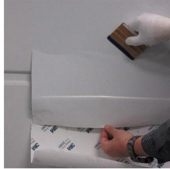
Die Folie wird mit dem Daumen oder mit einem Handroller (3M™ Roller S und L) in die Vertiefung verklebt.
